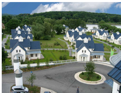
10 Ferienhäuser am Schwielowsee
