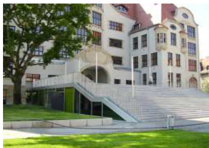
Gutenberg-Gymnasium Erfurt, Komplettsanierung
