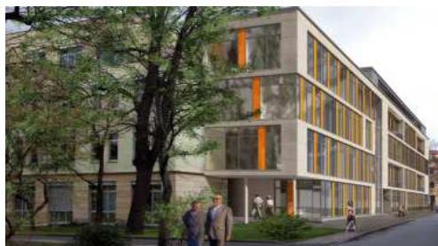
Krankenhaus Dresden-Friedrichstadt, Investition 17 Mio. €
