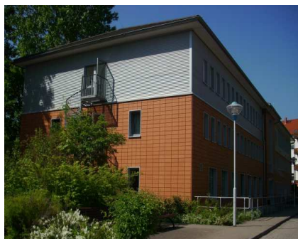
Neubau Landratsamt in Döbeln
