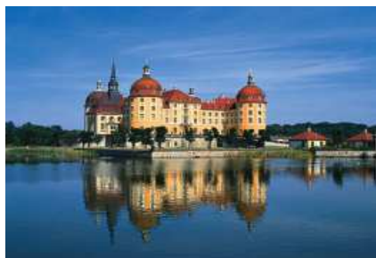
Schloss Moritzburg - komplette Sanierung
