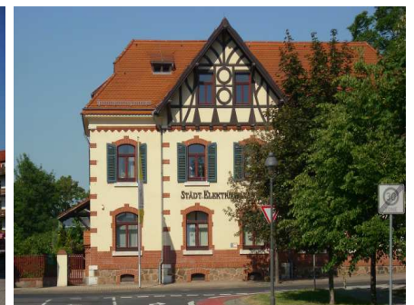
Sanierung Stadtwerke Döbeln
